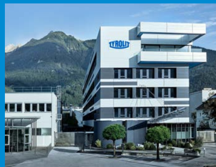
Sede central de TYROLIT en Schwaz (Austria)
